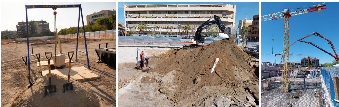
Estat de les obres del projecte de 101 habitatges (octubre 23-febrer 24-abril 24)
